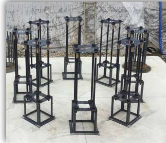
基礎鉄骨アンカー
