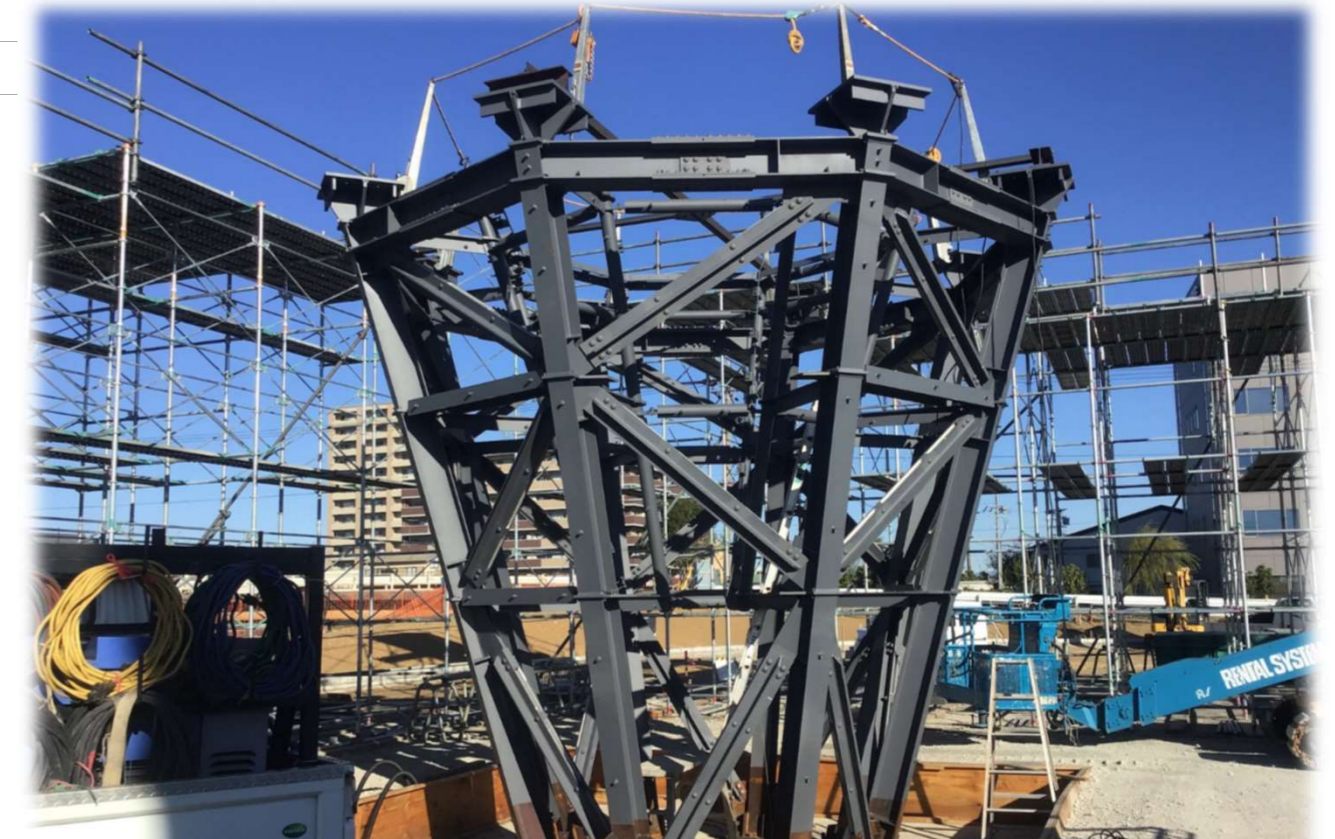
下部鉄骨建て方
