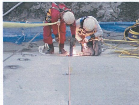
①斜面に定規アングル通り出
