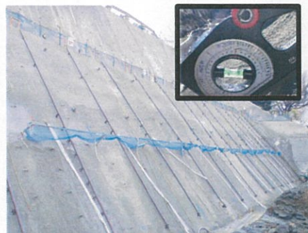
③定規アングル完了 斜度49° 確認
