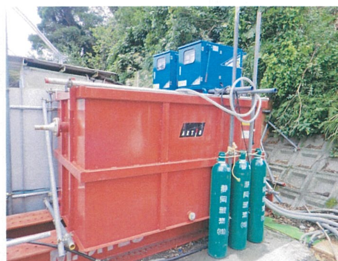
タンクを経由することで浮遊物を分離沈殿させ中性化することが可能
