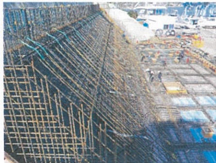
⑦上筋施工
