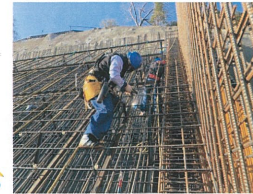
斜面にてセパ溶接
