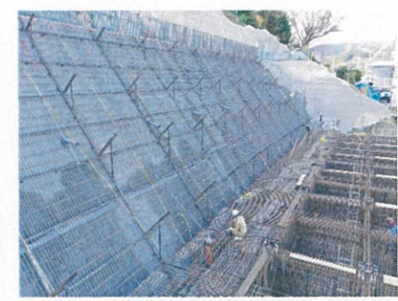
⑤下筋施工
