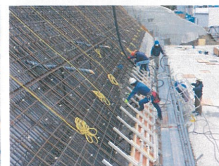
⑩1段目コン打状況
