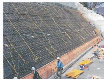
⑧型枠施工 ※型枠は工区ごと転用できるように割付
