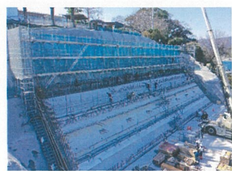
⑫斜面での擁壁擁壁完了
