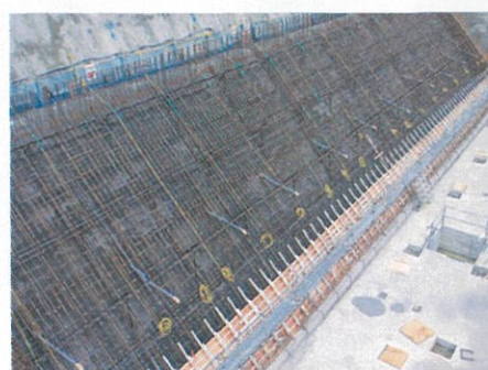
⑨1段目打設足場完了 ※足場は工区ごと転用ユニットで組立、レッカー
