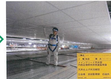
軽量天井完了検査
