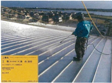
既存屋根水洗い
