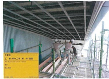
既存軒天撤去
