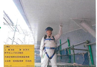
軒天完了検査
