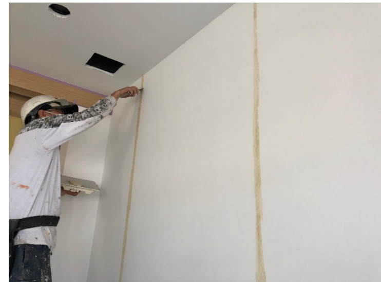
下地クロス張り完了後塗装前パテ処理状況
