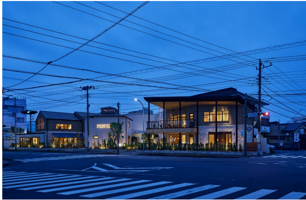
照明点灯時 外観
