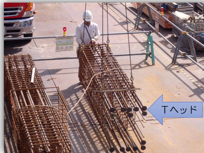
↑ 鉄筋組立材吊荷状況
