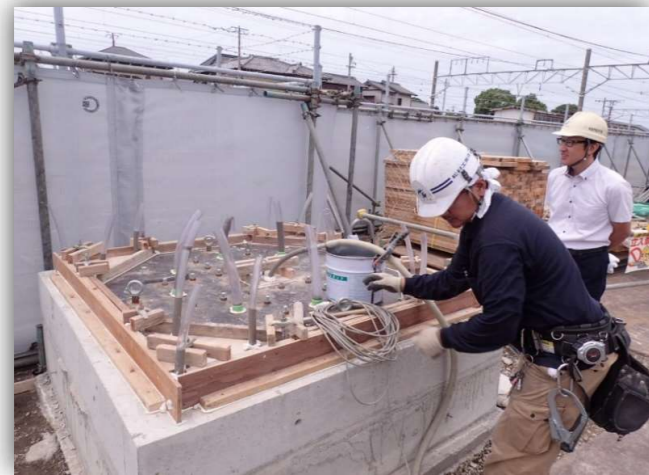
↑ 免震グラウト圧入試験（モックアップ）状況
