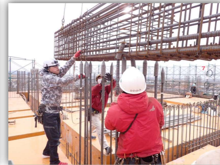
↑ 鉄筋組立材設置状況
