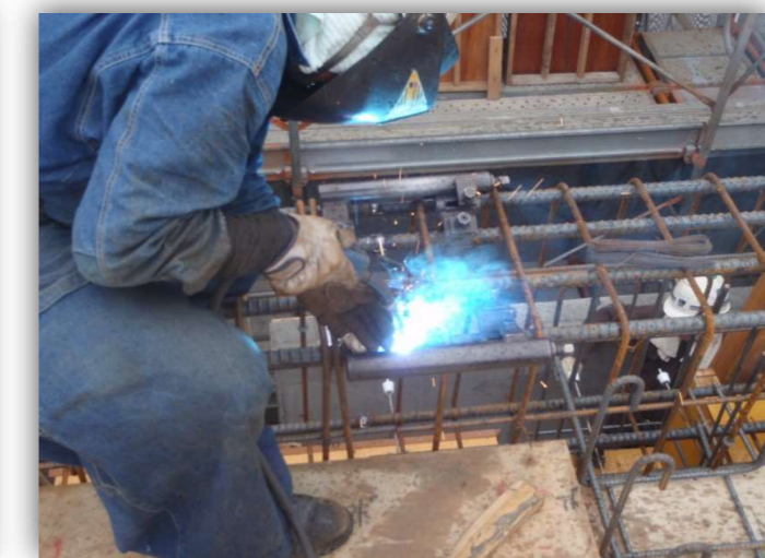
↑ 鉄筋梁継手溶接完了状況
