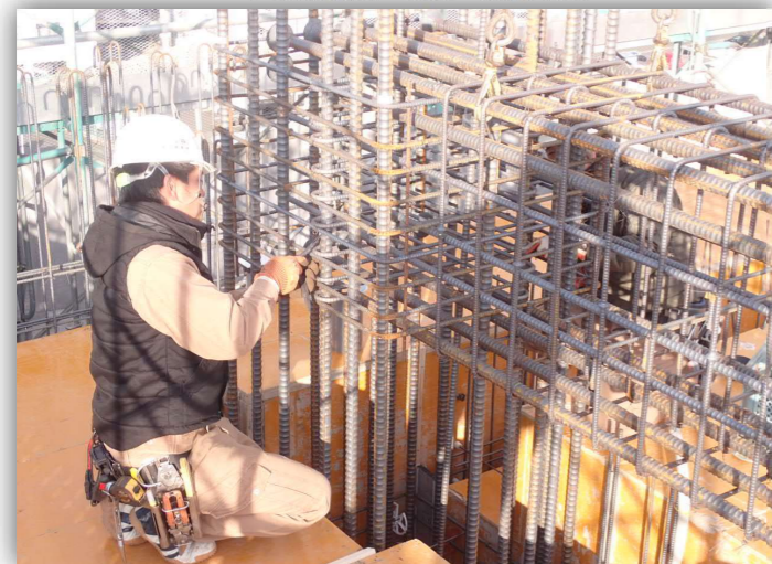
↑ 鉄筋組立材設置状況
