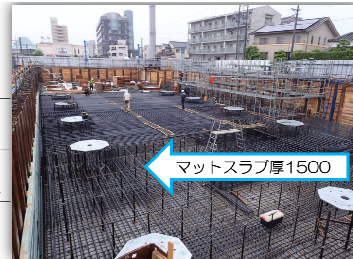
基礎マットスラブ（厚1500）配筋・免震装置アジャスター設置状況
