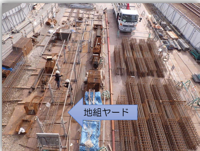
↑ 鉄筋組立加工場状況
