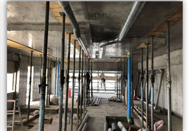
↑ 次工程作業状況
