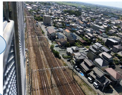
↑ 外部足場上から線路近接状況
