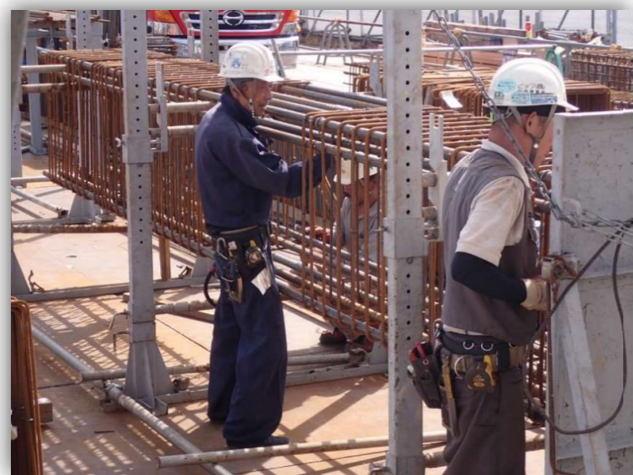
↑ 鉄筋組立加工場状況
