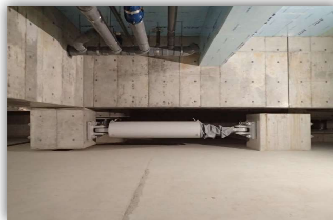
↑ オイルダンパー設置状況
