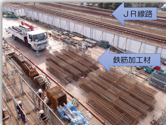
↑ 鉄筋組立加工場状況
