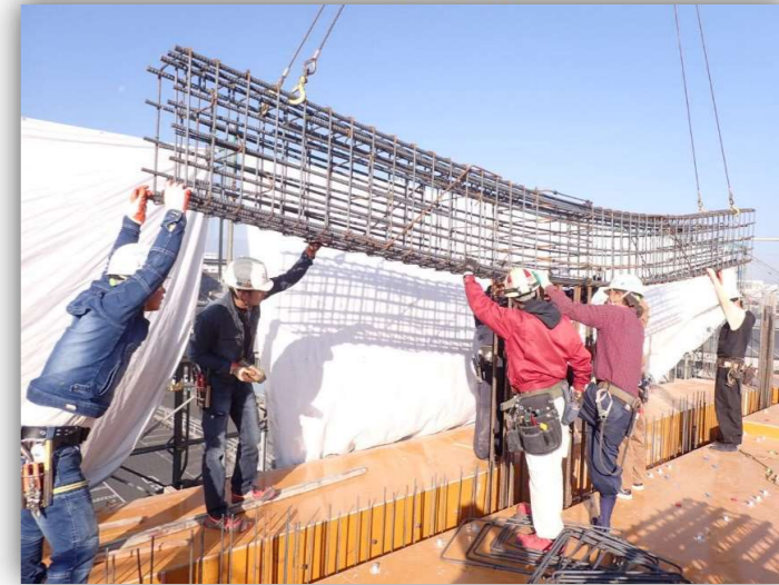
↑ 鉄筋組立材設置状況
