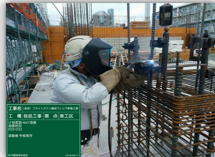
↑ 鉄筋柱継手溶接状況
