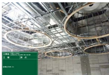
現場施工状況 (LGS)
