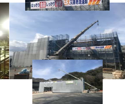
現場内の照度確保により安全性を確保
