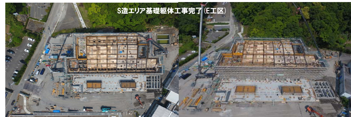
施工数量が多い1階躯体工事完了後の着手を最低条件とし、S造エリアの鉄骨建て方時期の逆算によりS造E工区基礎工事着手時期を決定。またRC工区躯体工事の工程を主軸とし、S造基礎工事は鉄筋型枠工事の隙間に当てはめる工程をとすることで、施工班を追加することなく工事を進捗した。
