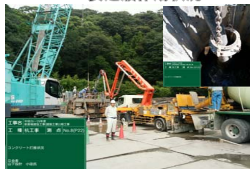
コンクリート打設状況
