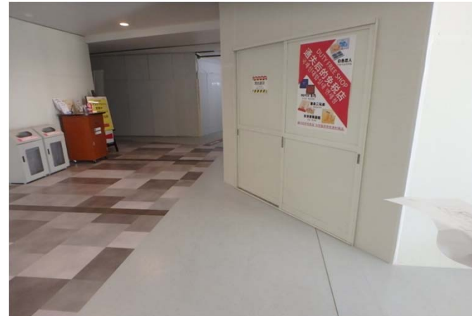
実際に施工した仮間仕切壁 (LGS下地+PB1枚貼)
