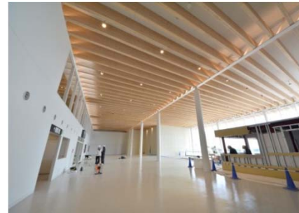
西側増築部ハイブリット梁(本体工事)
