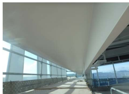
スクリーンボックス取付状況
