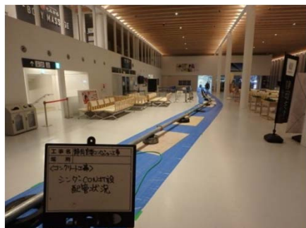
コンクリート打設状況 内部配管状況
