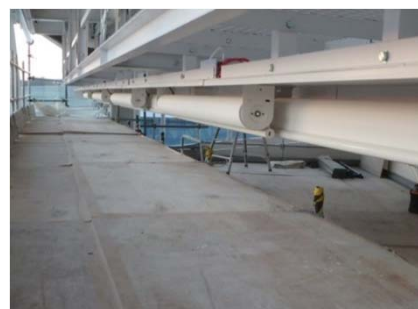
ロールスクリーン取付状況
