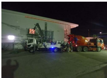
コンクリート打設状況 西側増築外部
