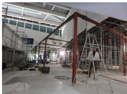
騒音：鉄骨建方
