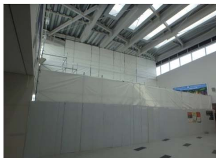
仮設足場組立状況
