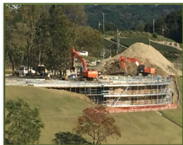
基礎工事 擁壁部
