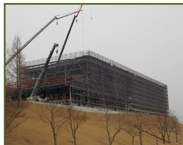
屋根 折板現場成形荷上げ
