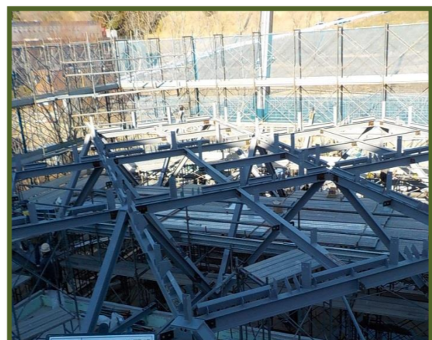
屋根面鉄骨建て方
