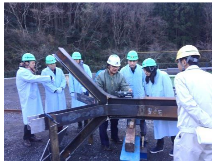
柱製品検査状況
