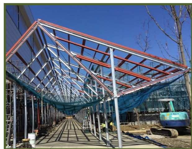
回廊 鉄骨下地
