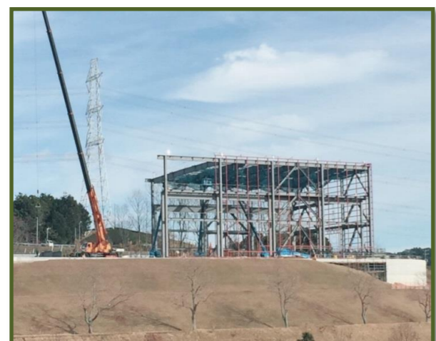
鉄骨建て方開始
