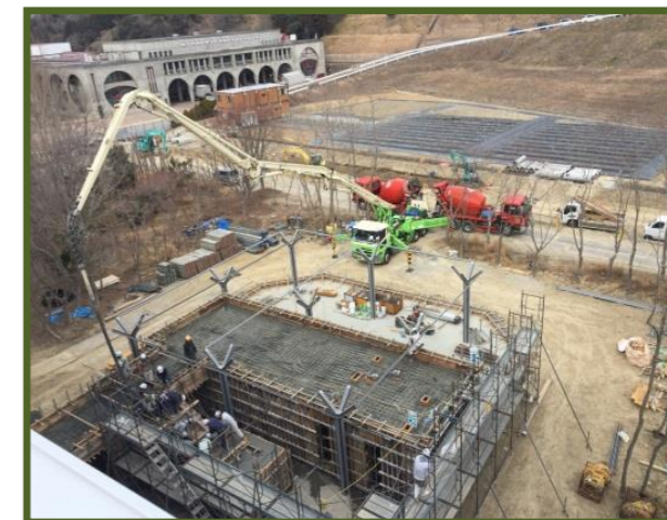
内部躯体施工中
