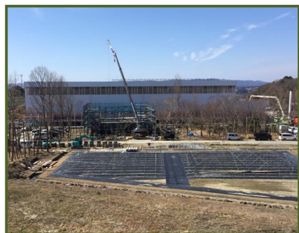
西面足場解体完了 回廊・エレベーション棟施工中
