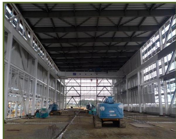
工場内 塗装・電気・機械施工中
