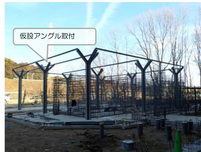
鉄骨柱施工状況 上部アングル固定
