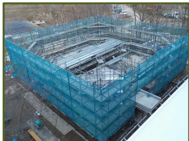
内外部足場設置
