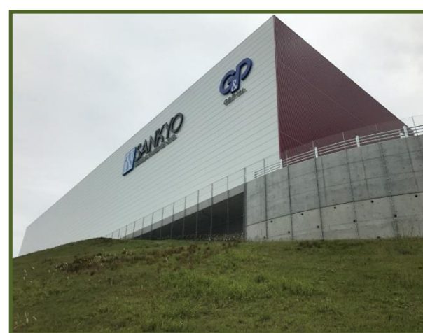
工場 南西面 擁壁・法面
