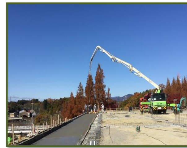
西面 キャノピースラブ 打設状況
