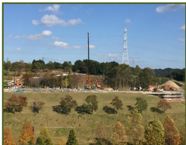
基礎工事 全景
