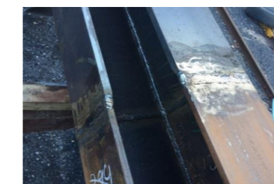
溶接及び研磨状況確認
