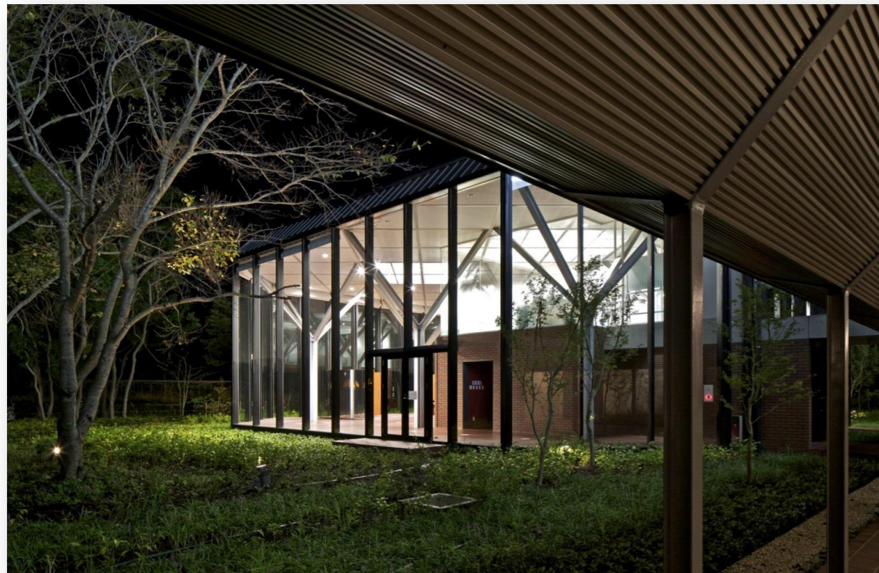
回廊～レセプション棟
