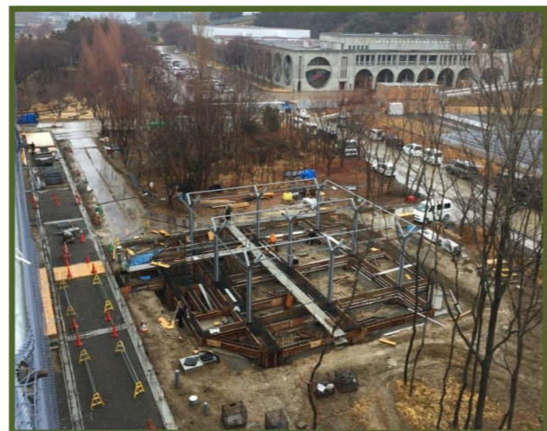
基礎工事中 鉄骨柱設置
