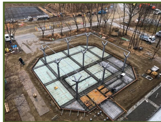
土間配筋施工中
