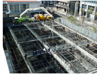
基礎躯体工事
