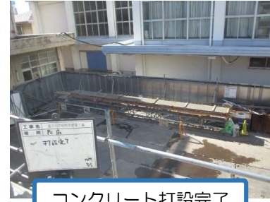
コンクリート打設完了
