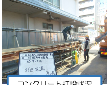
コンクリート打設状況
