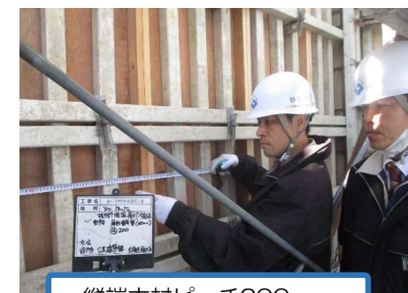
縦端太材ピッチ200mm
