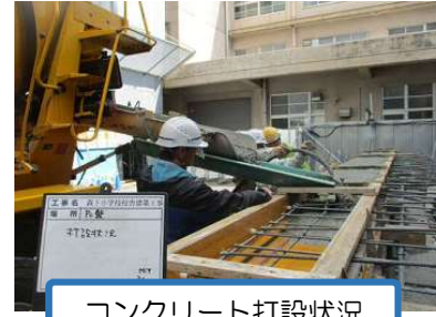
コンクリート打設状況
