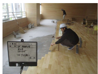
フローリング施工状況
