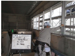
サッシ取付状況
