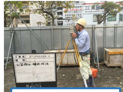
光波測距儀での測量状況
