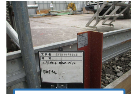
反射シール貼付け状況
