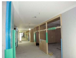
間仕切施工状況
