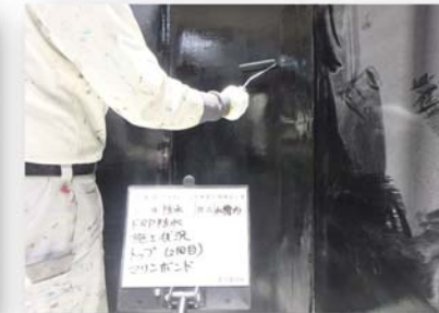
• トップ（マリンボンド2回目）施工状況
