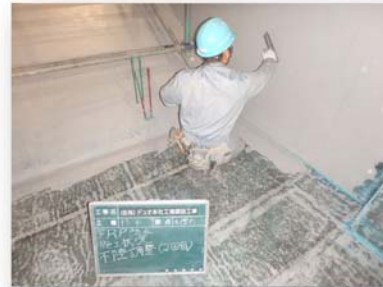
• 不陸調整（2回目）施工状況
