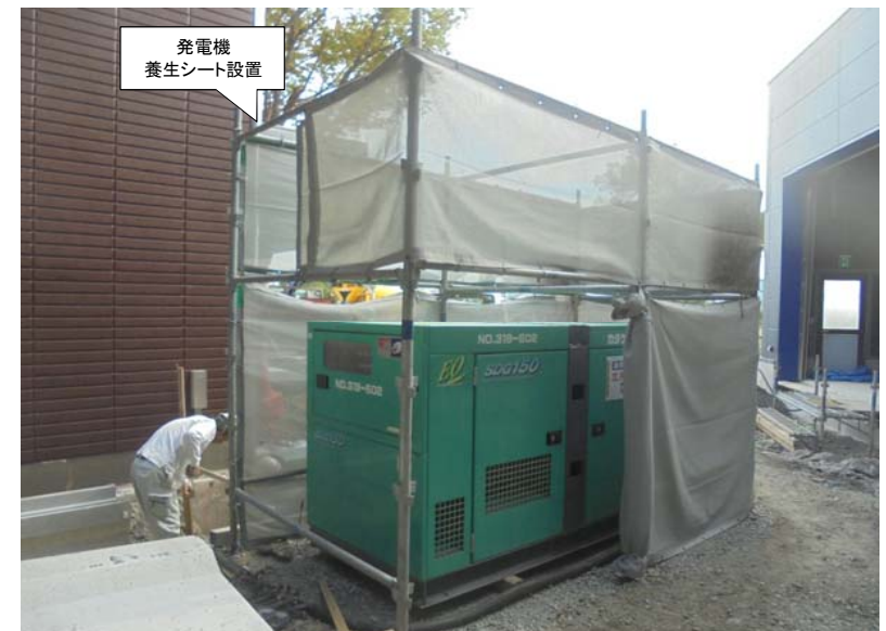
【 機械養生状況 】 外部への音漏れを低減できるよう、発電機は敷地内部に設置し、感電等の事故防止のため周囲を養生シートで囲った。
