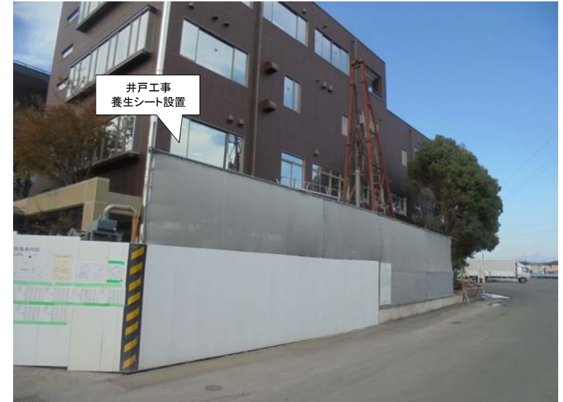
【 井戸工事養生状況 】
