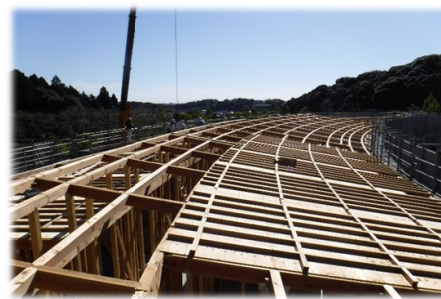
2F木造建方状況(屋根面)
