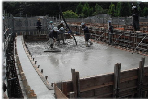
1F躯体コンクリート打設状況
