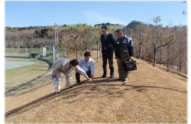
着手前既存法面
