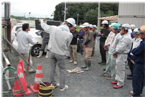
1F打ち放しコンクリート打設当日の関係者打合せ朝礼
