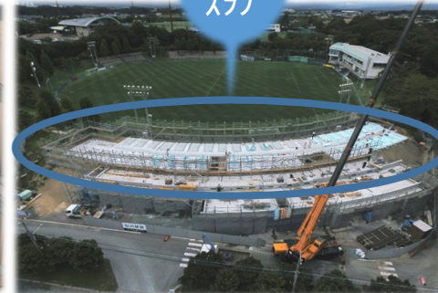
2土間下地施工状況
