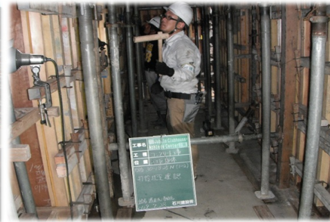
1F打ち放しコンクリート締め状況
