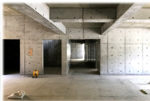
1F打ち放しコンクリート打設後型枠脱型状況
