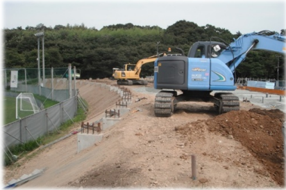
2F基礎部分法面埋戻し成形
