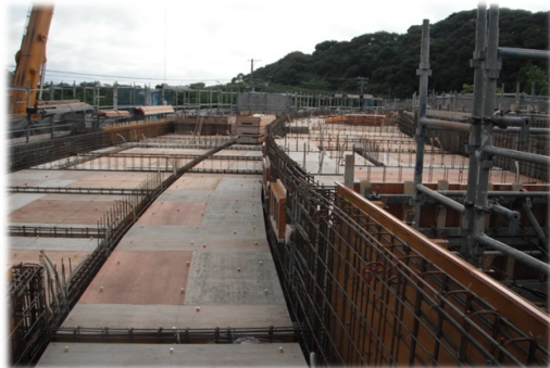
1F躯体型枠状況
