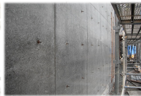
1F打ち放しコンクリート打設後型枠脱型状況(曲面壁)
