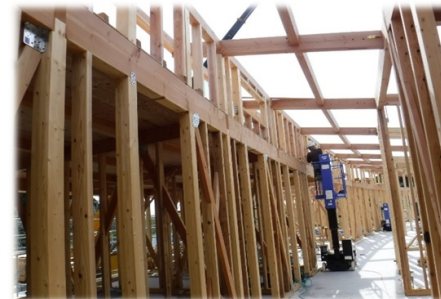
2F木造建方状況
