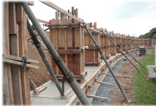
2F土間受け支柱型枠状況
