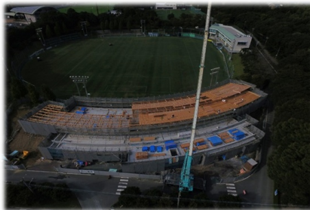
2F木造建方状況(上空より)
