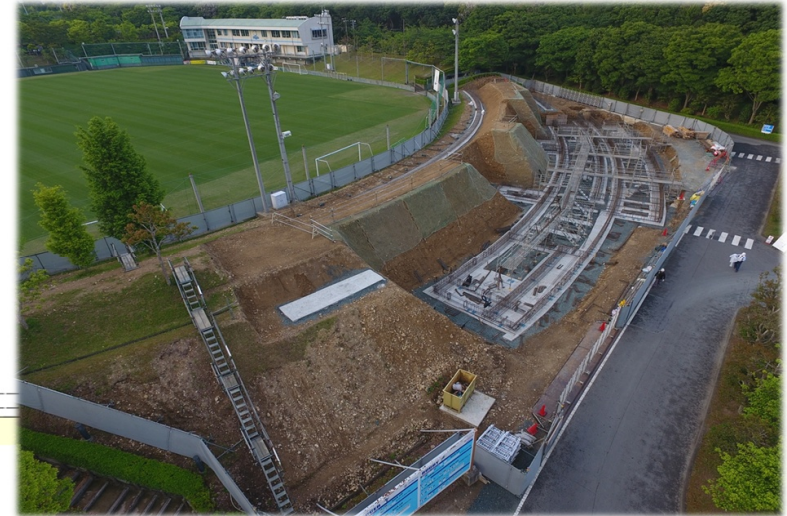
法面、根切り基礎工事状況
