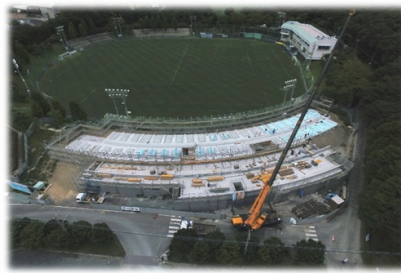
2F基礎土間下地
