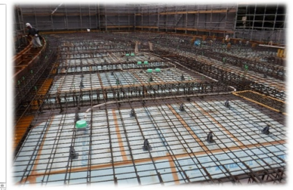
2F基礎配筋、アンカーセット状況
