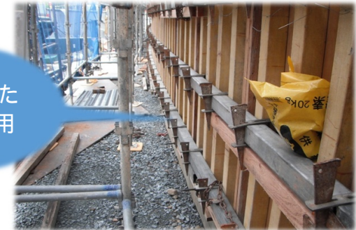
1F躯体曲面型枠状況
