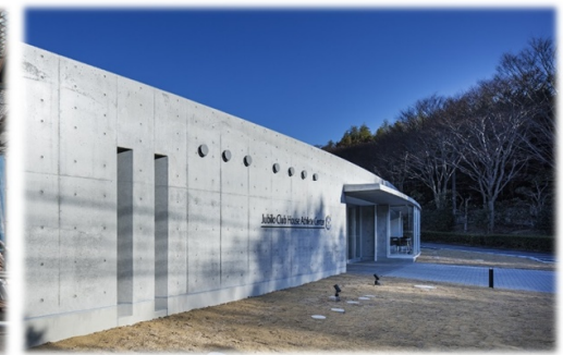
1F打ち放しコンクリート曲面壁
