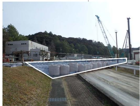
1-④ 乗り入れ部道路勾配による車両傾斜の解消（土留め設置）
