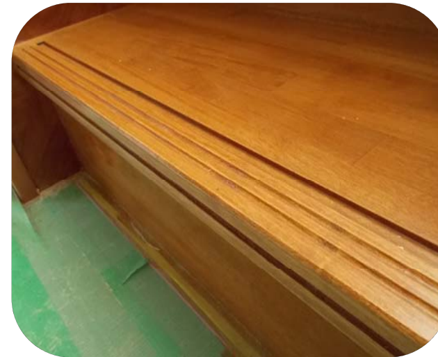
《蓄光材詰め込み前》 造作階段に彫り込みを施す
