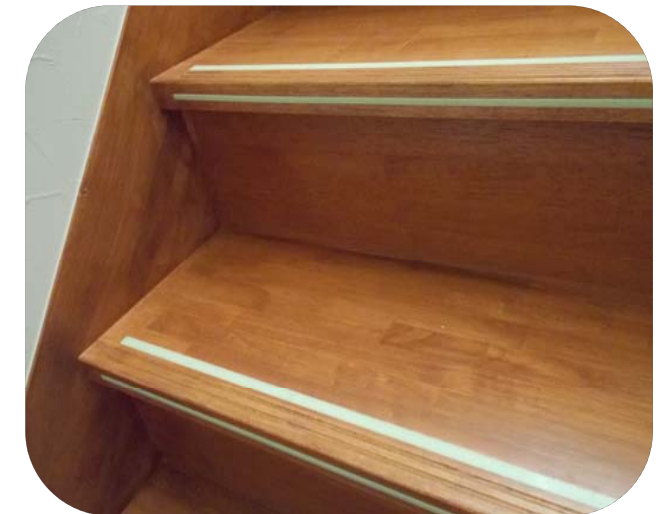
《蓄光材詰め込み後》 段板とフラットに納まる
