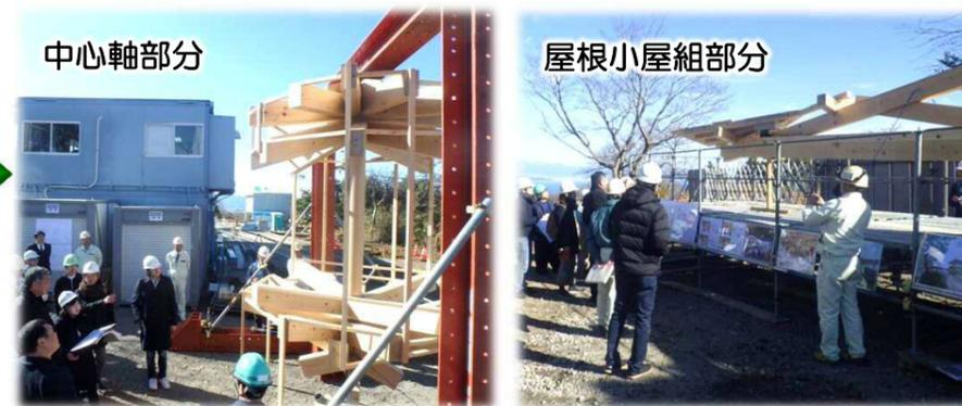
BIMで検討した結果に基づき中心軸部分と屋根小屋組部分の1/1スケールのモックアップを製作し、監理者に確認して頂きました。
