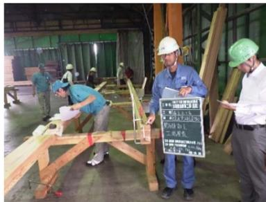
全長、断面寸法を加工図と照合
