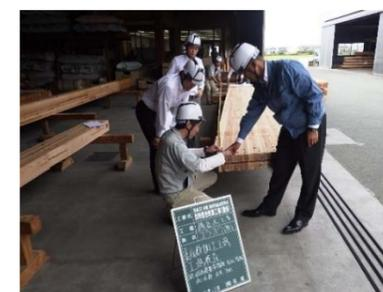
柱全長断面寸法を加工図と照合
