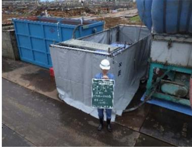
設置型発電機は防音シートで囲い音漏れに配慮した。
