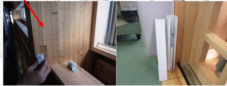
高窓のカーテン開閉装置の検討滑車の配置を事前に検討して滑車・ひも・プリーが目立ちにくい配置、使い勝手が良く、安全性にも配慮した施工を行った。
