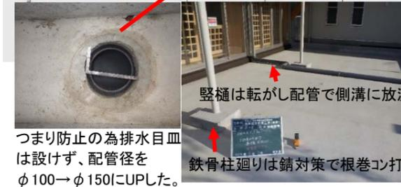
縦樋は転がし配管で側溝に放流
