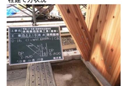
③. トラス組立て トラス地組台を計画し施工順序・方法を細かく検討し、安全に早く精度良い施工を目指した。
