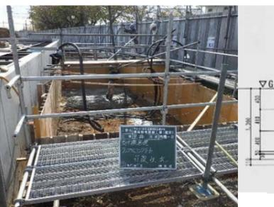
受水槽基礎、プール・擁壁取合ラップルコンクリート打設状況
