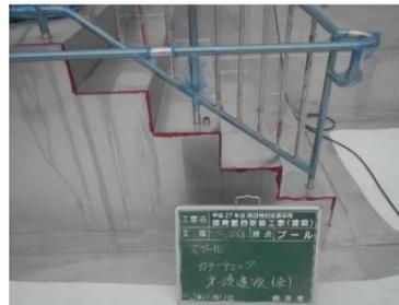
水漏れが無いようにプール据付後、溶接部をカラーチェック、バキュームテストで確認
