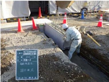
設計では横断側溝が現場打ちコンクリートであったが、工期短縮、カド欠け防止の為、2次製品化した。
