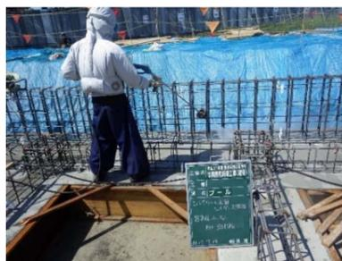
打継ぎ面は高圧洗浄(30MPa)で目荒しを行い、コンクリートの密着を良くした。
