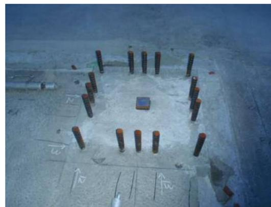
柱筋レベル・位置測定、レベル調整用プレート設置状況。
