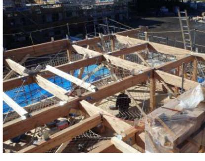
軸組壁工法の接合金物
